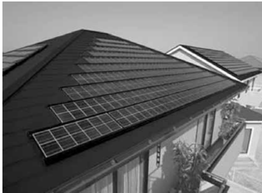
الشكل رقم 6-3: خلايا شمسية مثبتة على سطح منزل (بإذن من مؤسسة كيوسيرا للطاقة الشمسية)
